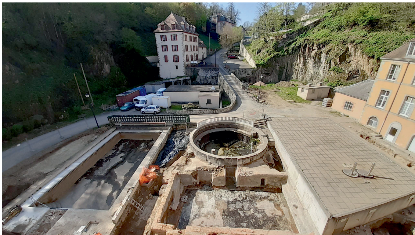
EVAUX-LES-BAINS - Les Thermes - Vue prise vers le nord, de gauche à droite: piscine D, bassins B et C, piscine A (emplacement du local technique).
