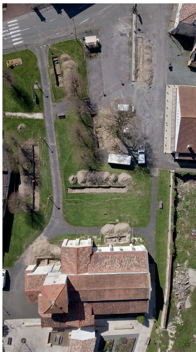
ANDILLY, Bourg, fig. A : vue de l'opération de diagnostic depuis un drone. SAD17
