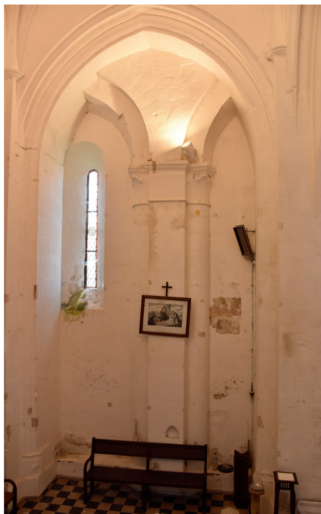
MONTILS, église Saint-Sulpice, fig. 2 : Photographie du mur sud avec les vestiges d'une rotonde, englobée dans les bases du clocher.
