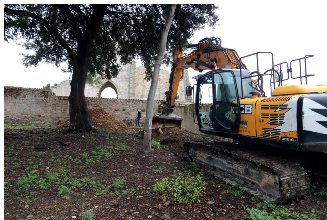
MARANS, route de La Rochelle, réalisation d'une tranchée de diagnostic sur les abords de l'église Saint-Étienne, située dans le cimetière communal. AUBRY T. SAD17
