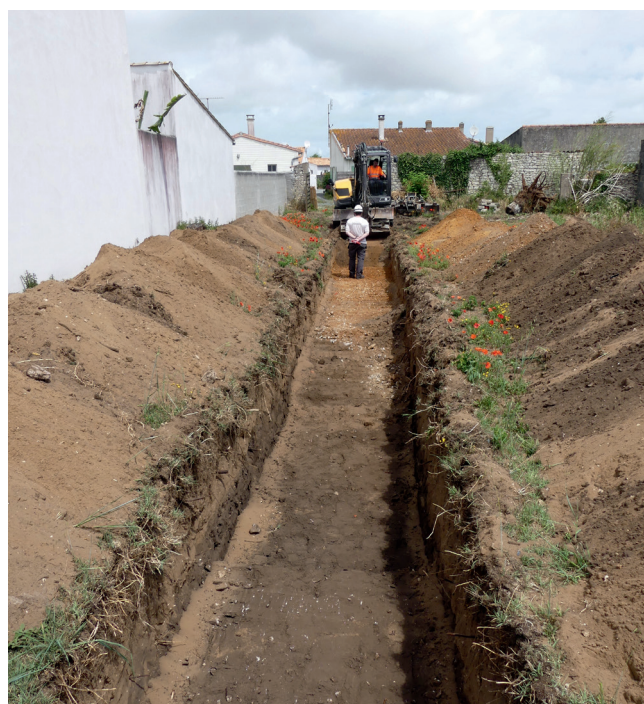
SAINTE-MARIE-DE-RÉ, impasse des Chirons, vue de la tranchée n° 1 en cours d'ouverture (cliché : C. Maitay)
