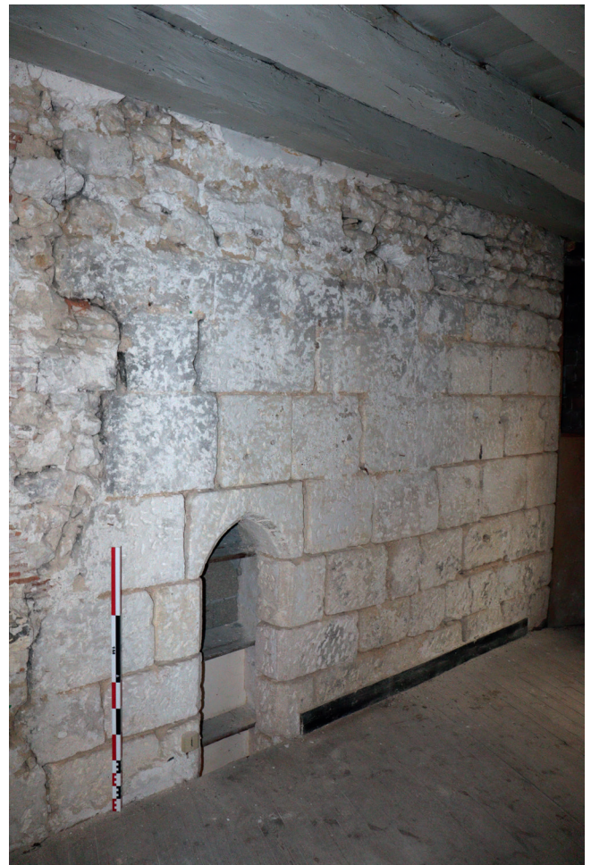
COGNAC, maison de la Lieutenance, fig. 1 : La baie et le parement en moyen appareil du mur mitoyen nord appartenant à une habitation du XIII e siècle (cliché : Atemporelle).
