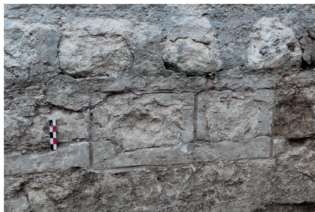
SAINT-CYBARDEAUX, Théâtre des Bouchauds, vue détaillée des joints tirés au Fer (cliché : L. Carpentier)
