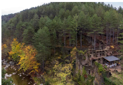
Vue générale du site. © Jean-Charles Méaudre.
