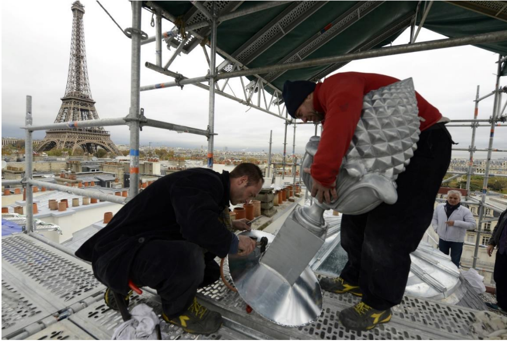
Figure 1 Soudage d'un ornement sur son socle © Gilles MERMET, 2016
