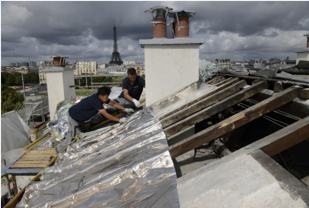
Figure 2 Pose d'un isolant © Gilles MERMET, 2018
