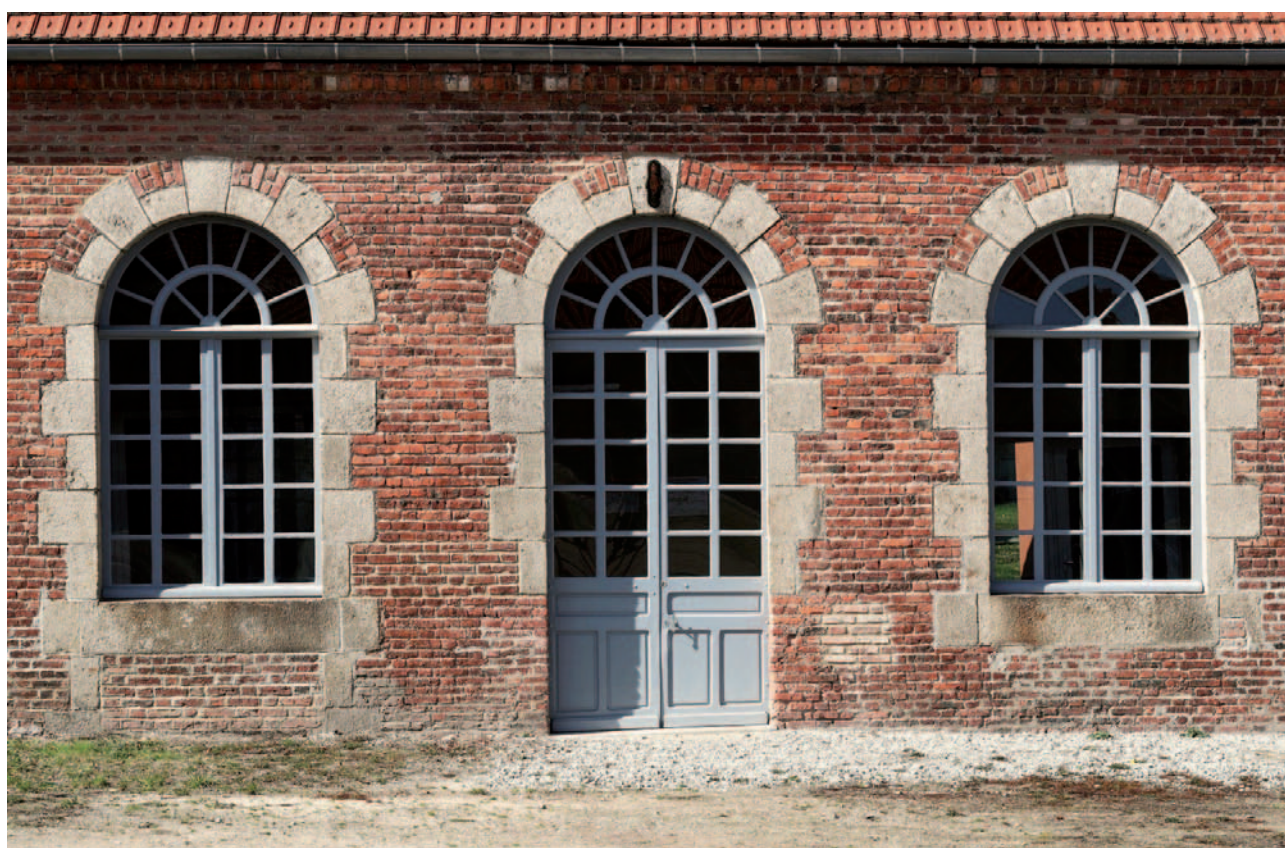
Aubusson (Creuse), Les anciens ateliers de la compagnie des Houillères d'Ahun, détail des baies cintrées des ateliers après restauration. 4 e quart 19 e siècle.
