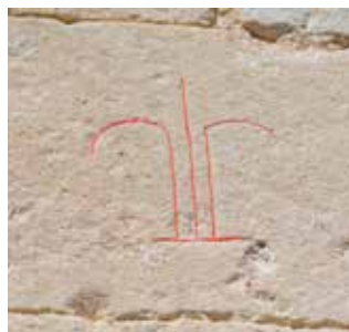
Marques de tailleurs de pierre sur des blocs du parement extérieur de la collégiale.
