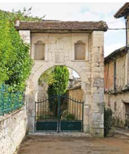
Portail d'entrée de l'ancien couvent des Ursulines, milieu du 17 e siècle, inscrit MH le 07/07/1977.
