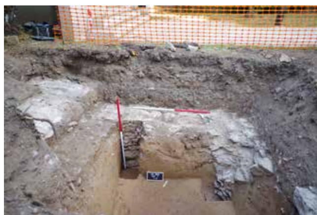
Fig. 2 : semelle de fondation et niveau de circulation.
