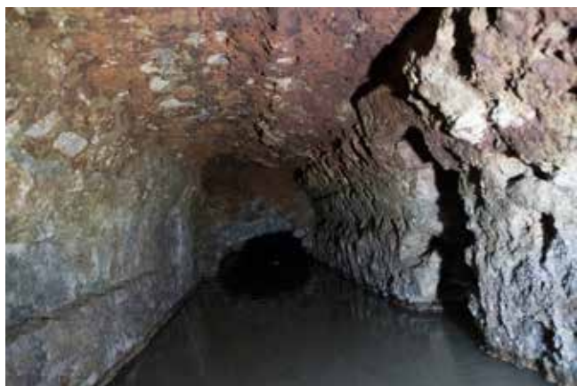
Fig 2 : chambre de visite vue vers le nord
