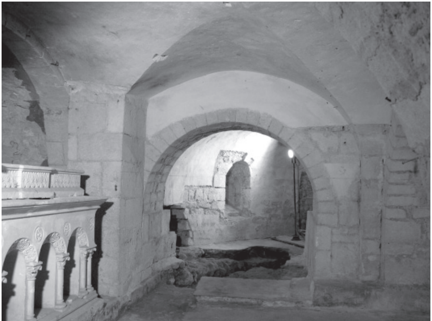
Ci-dessus : L'entrée du collatéral sud-est : tous les parements visibles sont des chemisages des parements primitifs (cliché : M. Chaillou, Hadès).
