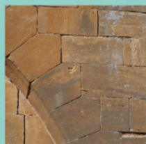
pierres de taille appareillées
