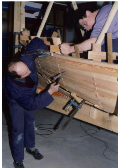
Photographie 13: Mise en place des rivets en cuivre
