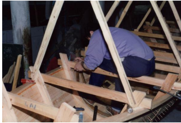
Photographie 12: Ployage des membrures (Photographie de la famille Marin, prise lors de la construction du batteliku Kuxto en 1993)
