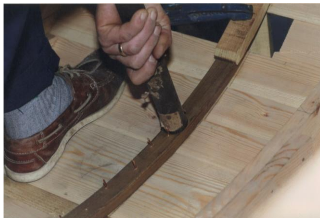
Photographie 14: bouterole servant à la mise en place des rivets
