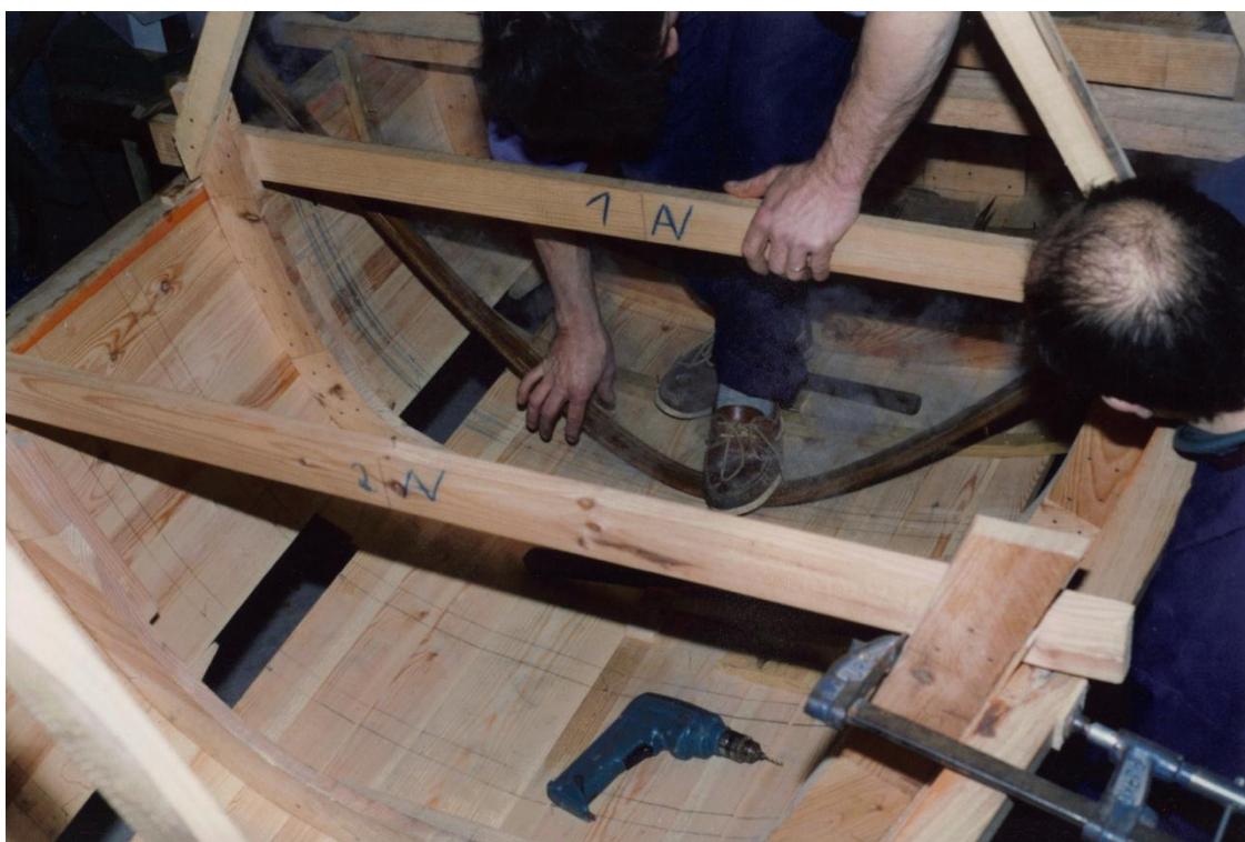
Photographie 11: mise en place d'une membrure (Photographie de la famille Marin, prise lors de la construction du batteliku Kuxto en 1993)
