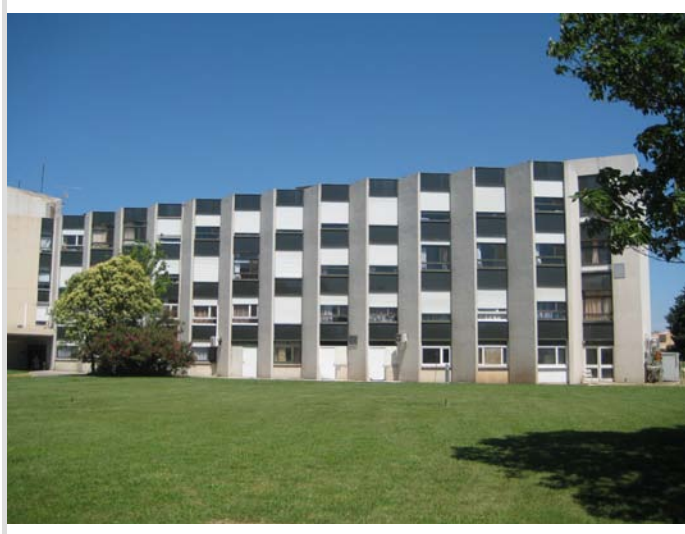
Détail de la façade principale (cl. EMJ, 2008).
