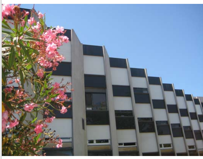
Détail de la façade postérieure (cl. EMJ, 2008).
