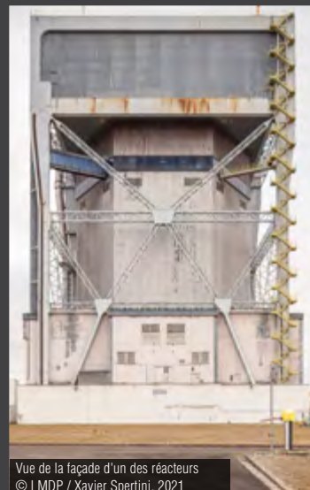
Vue de la façade d'un des réacteurs © LMDP / Xavier Spertini, 2021
