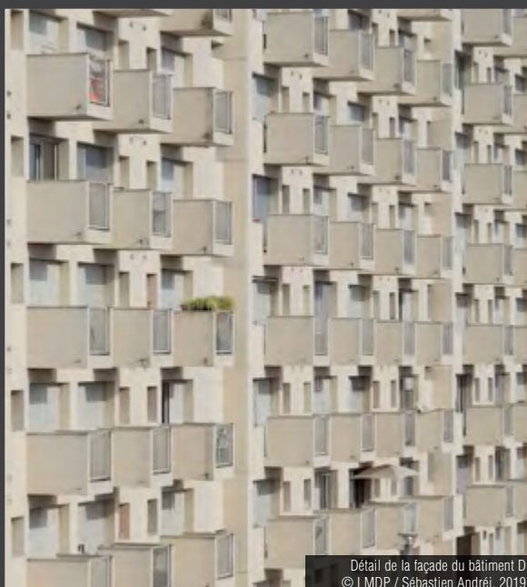
Vue de la façade orientale du bâtiment B et du socle commercial sur la rue Giraudeau © LMDP / Sébastien André, 2019
