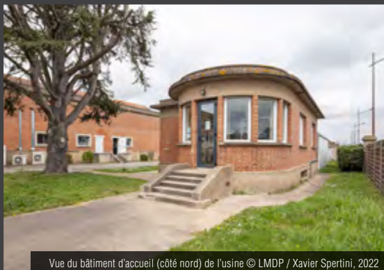
Vue du bâtiment d'accueil (côté nord) de l'usine © LMDP / Xavier Spertini, 2022
