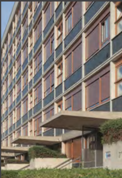
Profil des marquises en façade d'un bâtiment © LMDP / Sébastien Andréi, 2019
