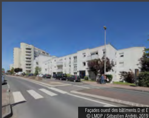
Vue des espaces de circulation extérieurs © LMDP / Sébastien Andréi, 2019
