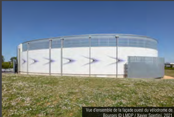
Vue de l'entrée du vélodrome de Bourges et de la façade nord-est © LMDP / Xavier Spertini, 2021
