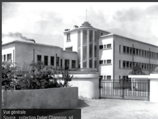
Vue de la façade principale de l'usine © LMDP
