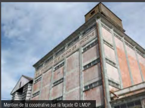
Mention de la coopérative sur la façade © LMDP
