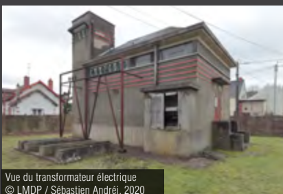
Vue du transformateur électrique et de l'ancienne maison du directeur © LMDP / Sébastien Andréi, 2020
