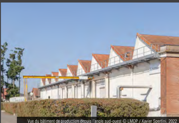
Vue du bâtiment de production depuis l'angle sud-ouest © LMDP / Xavier Spertini, 2022
