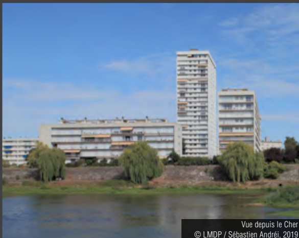
Vue de l'ensemble du secteur du carrefour de Verdun depuis le pont du Sanitas © LMDP / Sébastien Andréi
