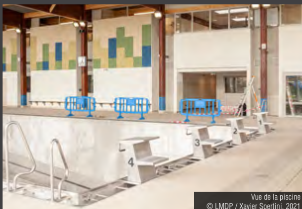
Vue de la piscine et du plongeur © LMDP / Xavier Spertini, 2021
