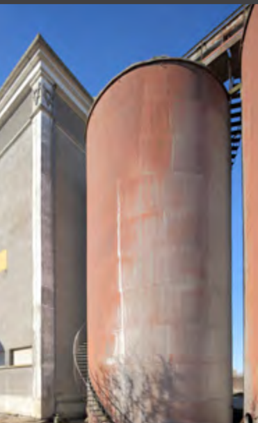
Veuzain, Silo de la gare d'Onzain © LMDP / Sébastien Andréi, 2019
