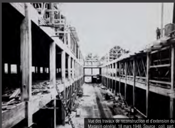
Vue des travaux de reconstruction et d'extension du Magasin général, 18 mars 1948. Source : coll. part.
