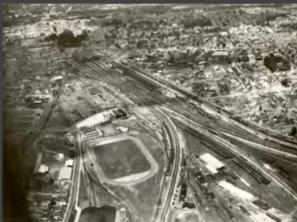
Vue aérienne du site du futur quartier du Sanitas, 1954 Source : AM de Tours, fonds Tourtet, 102 Fi 22
