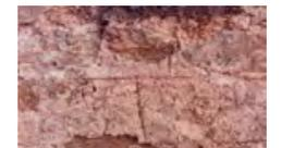
Moellons recouverts d'un enduit avec joints tirés au fer pour imiter le petit appareil.
