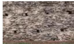
Rangées de trous de boulin parallèles (le parement a disparu, seul le blocage est visible).
