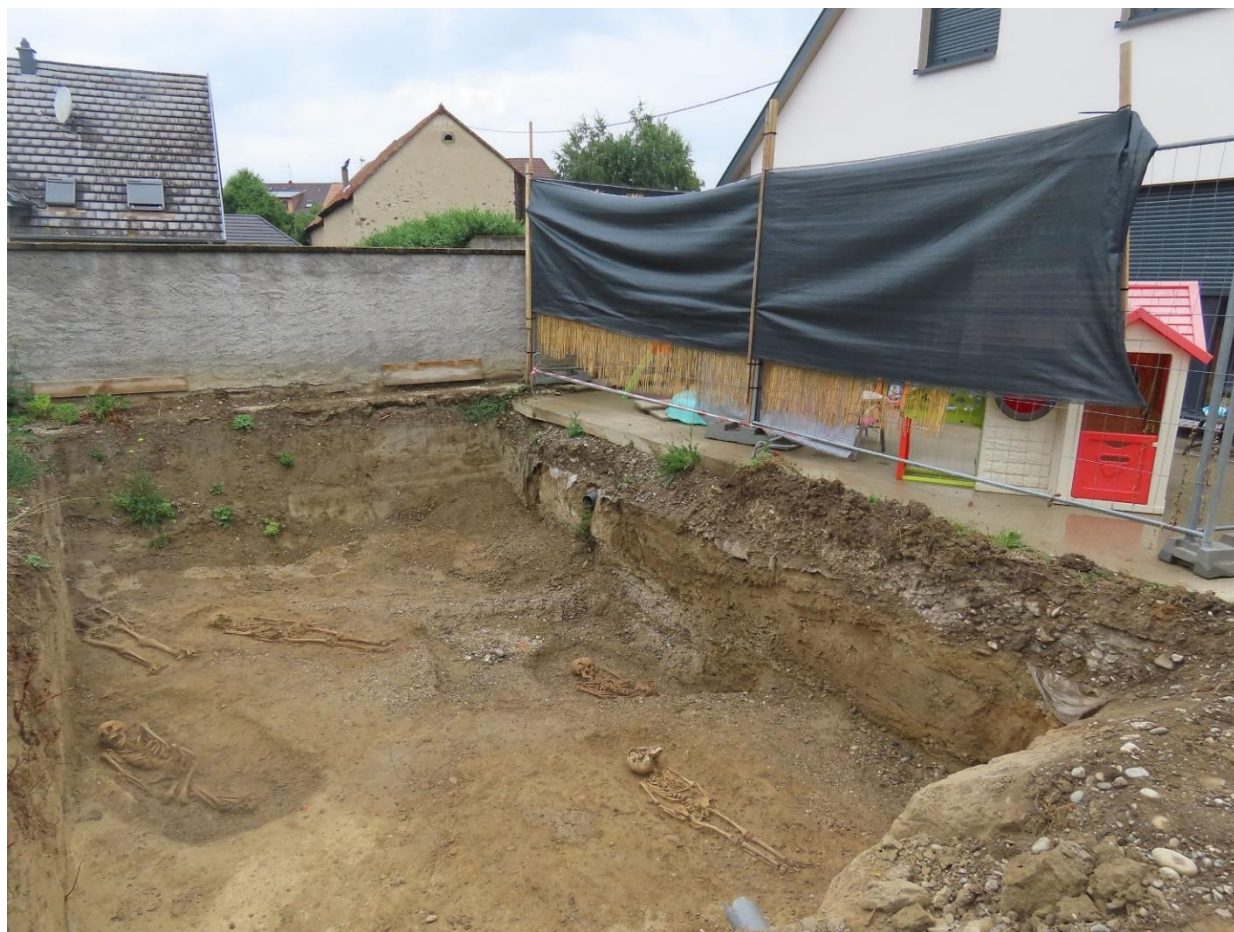
Fig. 1. Vue d'ensemble du chantier de Blodelsheim – Rue du Château d'Eau (ANTEA-Archéologie).
