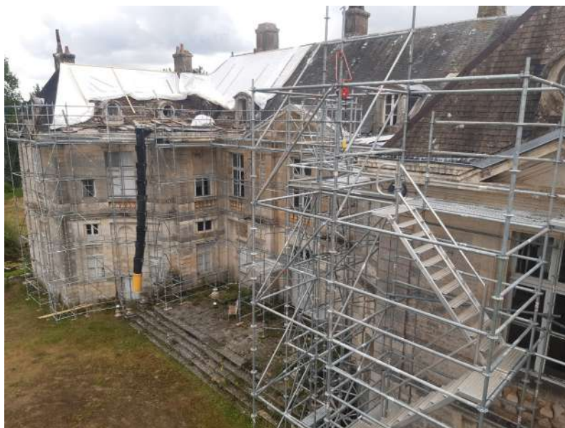
18-Lignières : restauration château
