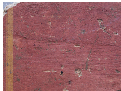
ill. 21: détail du lissage visible sur la couche picturale d'un enduit, 2013. Cliché S. Groetembriel.
