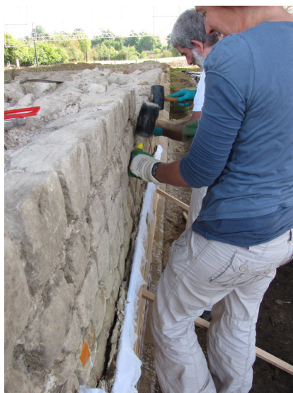
ill. 8: Vieux-la-Romaine (Calvados), forum. Dépose par un restaurateur d'une peinture murale conservée en place sur le mur: passage des lames pour désolidariser l'enduit du mur, 2010. Cliché M. Tessariol.
