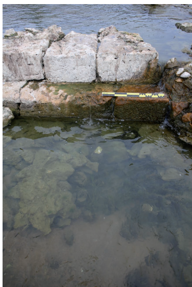
24 /// À l'arrière de la pile 8, les têtes des pieux prises dans le béton vues vers le nord-est (mire de 0,30 m). © Stéphane Brousse (Inrap)
