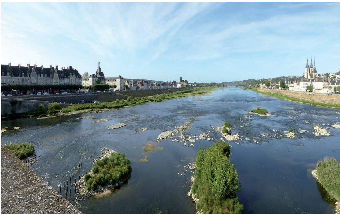
3 // La Loire vue vers le sud-ouest depuis le pont moderne Jacques-Gabriel ; au premier plan à gauche, les vestiges du pont provisoire en usage entre 1945 et 1948, au centre, les piles dérasées du pont de pierre médiéval détruit en 1716, au fond, le pont antique se signale par une ligne plus sombre. © Viviane Aubourg (DRAC CVL)
