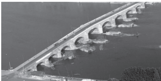
35 /// Le pont provisoire en cours de démontage alors que le pont est remis en circulation. La pyramide est, quant à elle, en projet de reconstruction © Roger Henrard (Région Centre-Val de Loire, Inventaire général).
