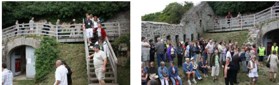
Passerelle d'accès et rampe herbue. © Office du tourisme de la pointe de Saire
