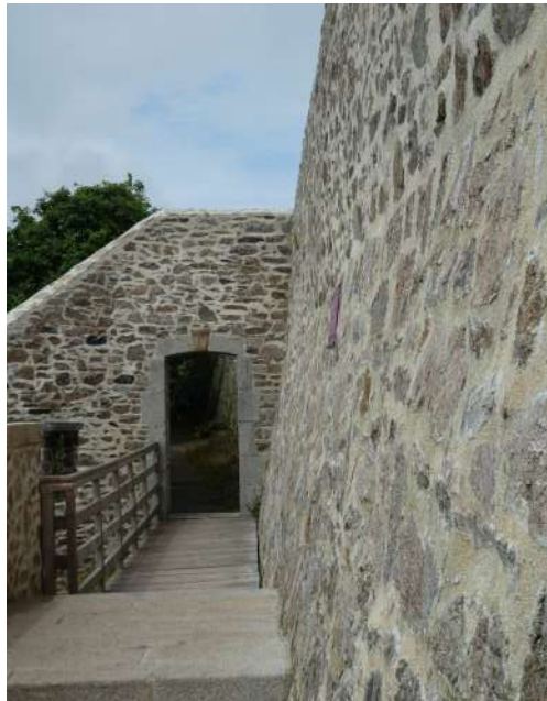
Partie du mur d'enceinte dé-végétalisée
