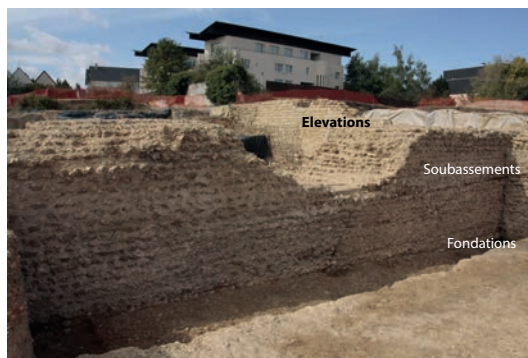
7 /// Soubassement du péribole oriental. Deux équipes de maçons ont œuvré à sa construction comme en témoigne le chaînage en biseau situé à l'aplomb de l'égout. © Direction de l'archéologie de Chartres Métropole
