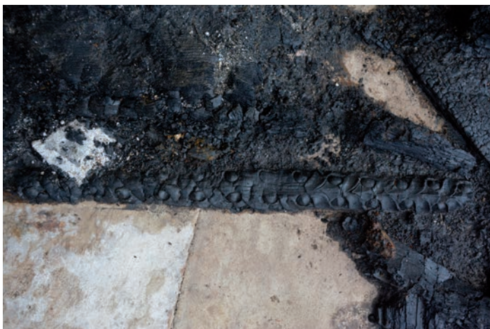
25 /// Composition décorative d'une tresse à ceillels sur une poutre de caisson. © Direction de
