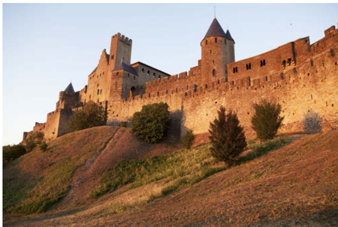
Cité de Carcassonne, front ouest, tour de la Justice et château comtal © Laurent Gueneau / Centre des monuments nationaux
