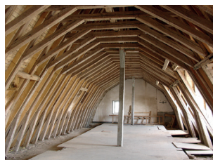
▲ Charpente du logis du prieuré du Louroux (Indre-et-Loire), © F. Audebrand
