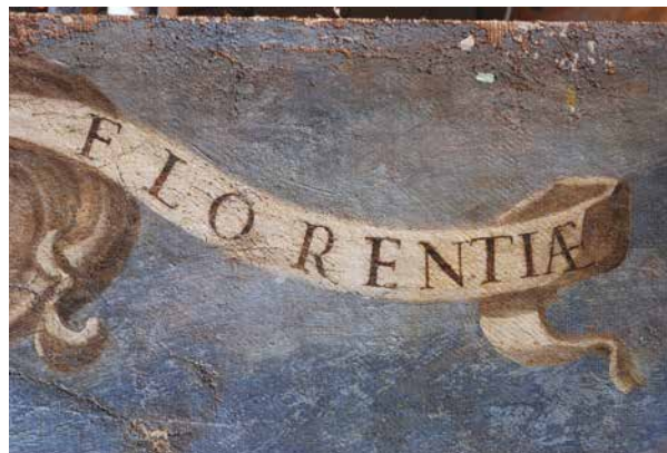
[1] Détail avant restauration.
