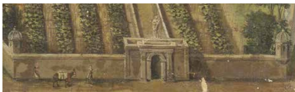
[1] Détail de la façade d'entrée après traitement / voir carte p. 14.
