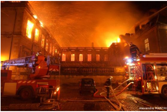
2 janvier 2003 : incendie du château de Lunéville d'origine électrique dans les combles de la chapelle du petit Versailles. Des éléments de toiture cèdent et traversent les planchers, propageant le feu sur plusieurs niveaux simultanément.
