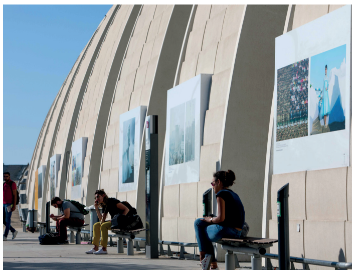
Installation sur la façade d'Avignon TGV crédits David Paquin
