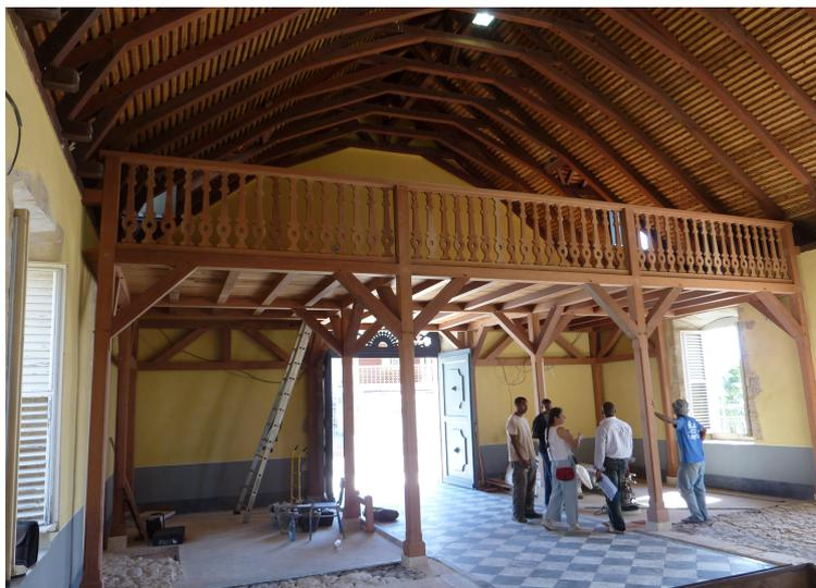
À cela s'ajoute la présence de sel dans l'ouvrage en raison de sa situation en surplomb du port et face aux embruns. Les menuiseries modernes à persiennes ont été reprises avec des sections plus larges et permettant d'éviter la pénétration de l'eau dans l'édifice.
