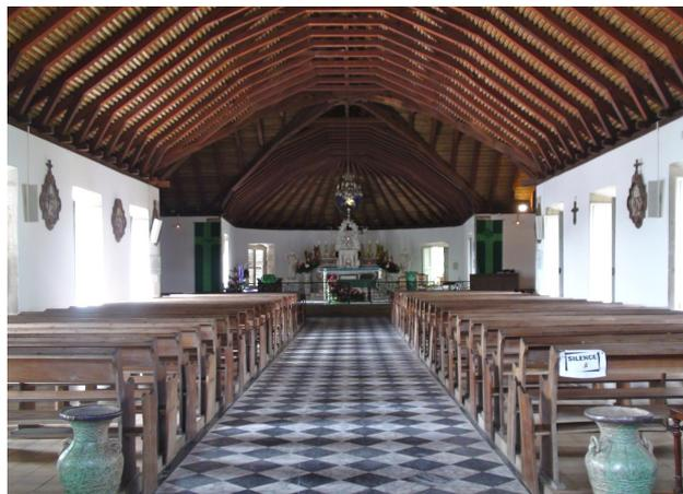
charpente en pitchpin d'origine avec sa toiture couverte en tuiles écaille posées sur des lattis en roseaux selon la tradition locale.
