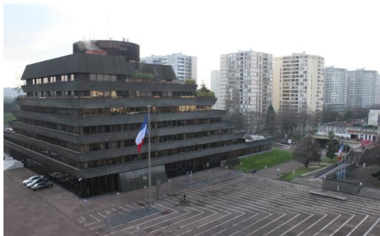
Préfecture de Seine-Saint-Denis à Bobigny
