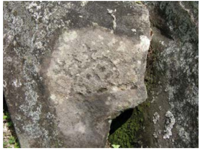
Fig 65 : bloc D après nettoyage à la vapeur et à la brosse douce. Cliché Oriol G. / LRMH.
