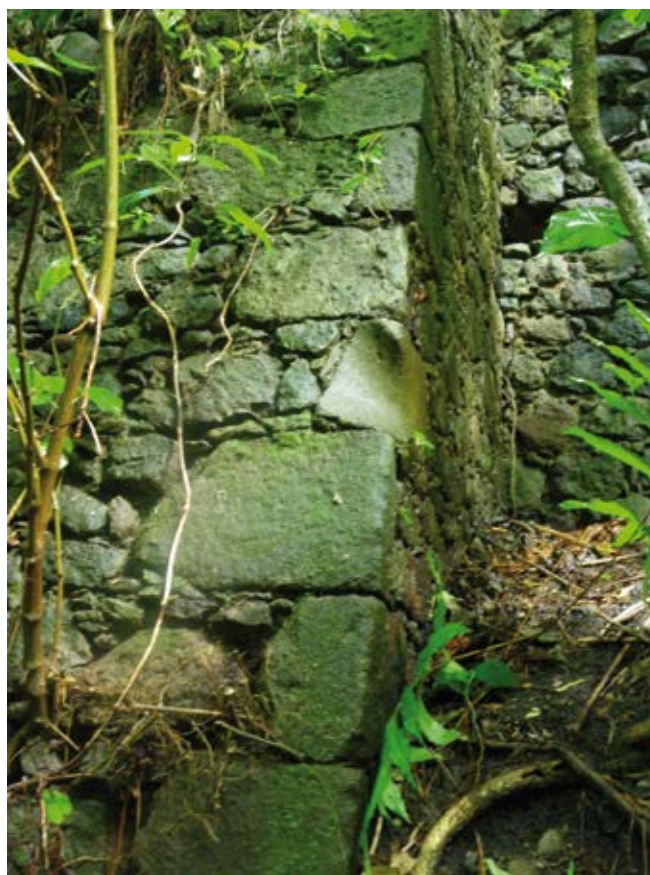
Fig. 55 : Mur de soutènement. Cliché Pelissier E. /AUT
