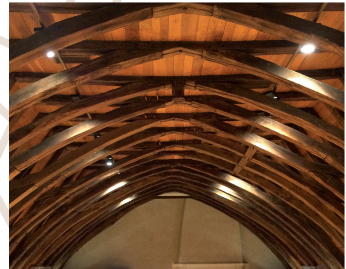
Salle sous charpente, XIV e siècle et restaurée au XVIII e siècle
