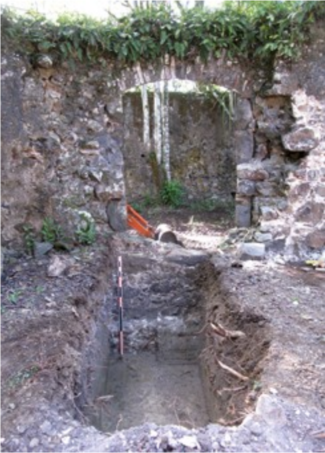
Fig. 2 : Observation des maçonneries et des niveaux associés.
