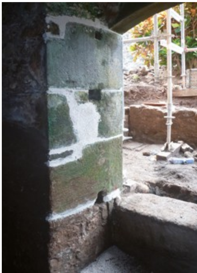
Fig. 3 : Vue du système de fermeture intérieur avec, au premier plan, le seuil d'origine, et, au second, le seuil rehaussé avec son sol aménagé en cours de démontage. Deux murs de soutènement sont visibles au fond.
