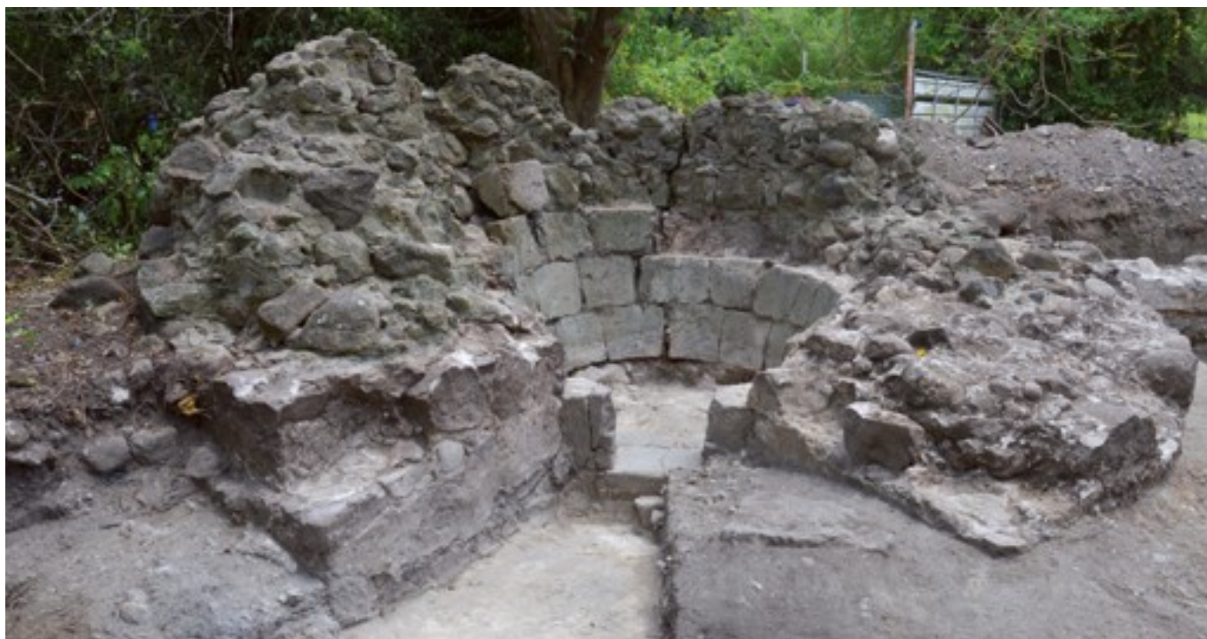
Fig. 3 : Four à chaux, porte du foyer et aire de déchargement.
