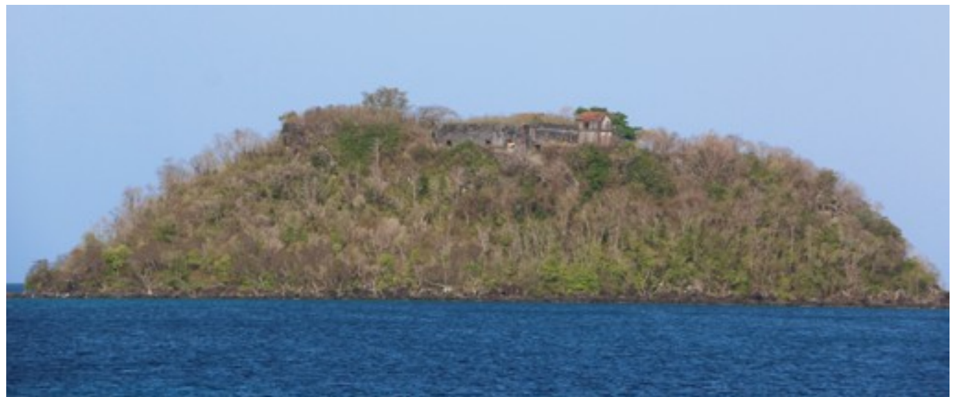
Fig. 4a : Bâtiment central, de l'îlet à Ramiers ( Les Trois-Îlets ).
