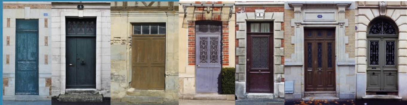
Porte pleine à simple vantail et à imposte pleine
