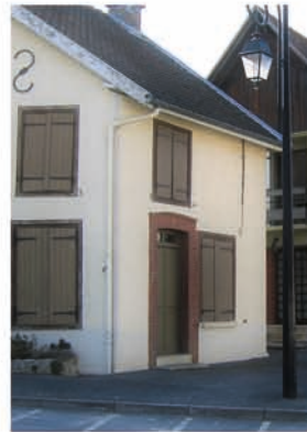
Porte avec imposte vitrée fixe en arc surbaissé avec marquise
