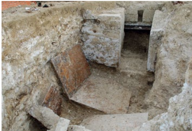
Vue générale du poste d'observation depuis l'est. Par sécurité, la paroi en béton située à l'est a été retirée. Par ailleurs, on observe, au nord, une dalle de couverture effondrée du boyau n° 140
