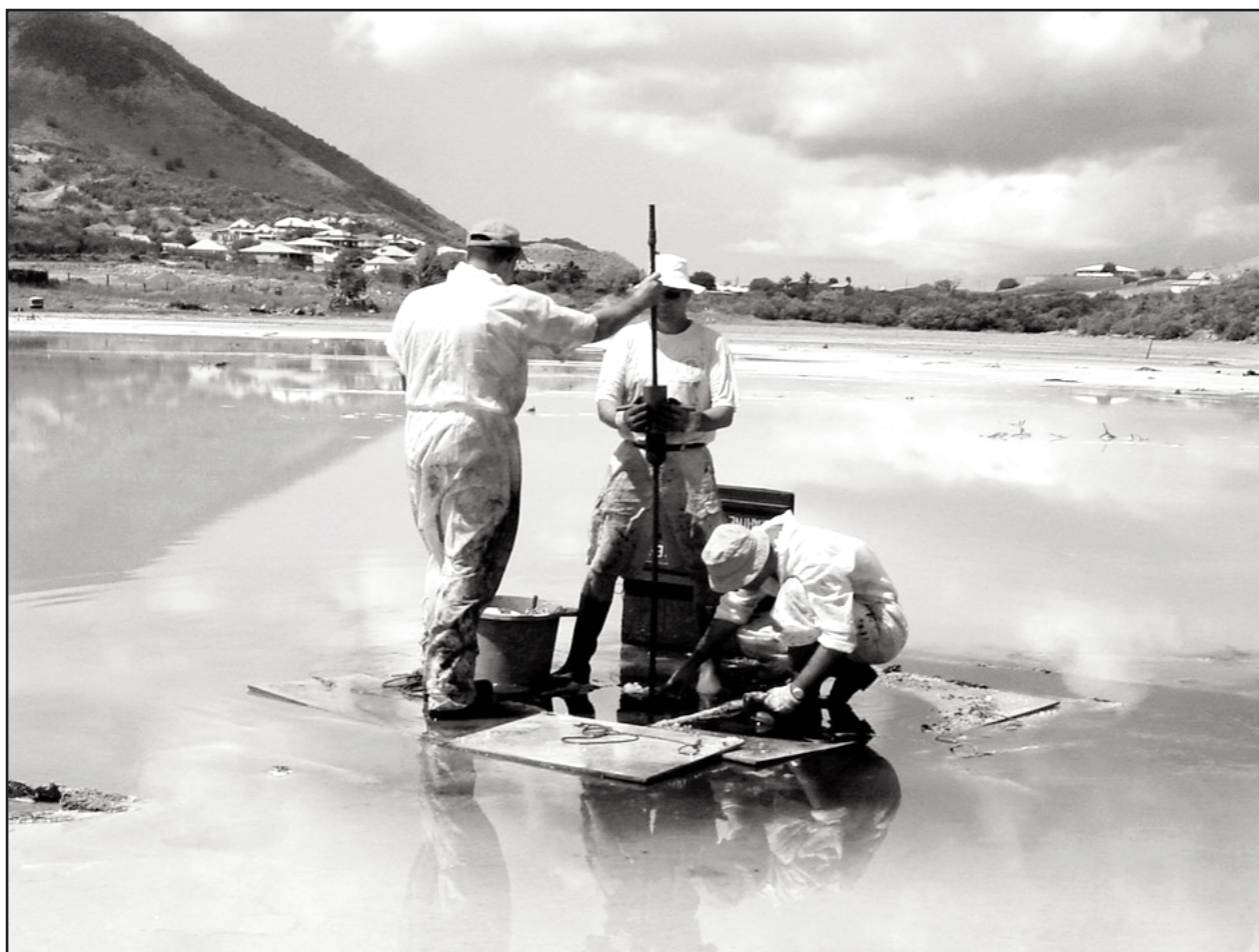
Saint-Martin Sondage au pénétromètre sur l'étang de Chevrise
