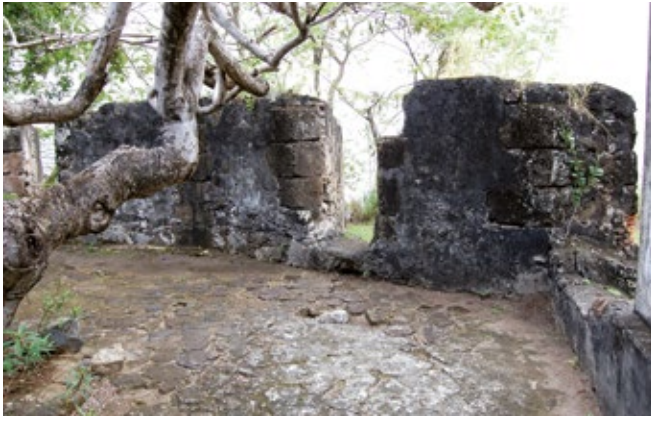
Fig. 2 : Le parapet et l'embrasure de tir de la batterie de la Pointe de la Batterie à Case-Pilote.
