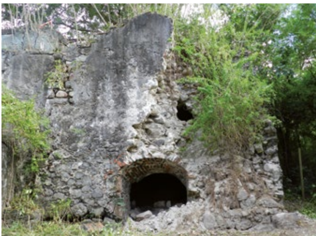
Fig. 1 : four de potier, vue de la façade sud-est (D. Ollivier).
