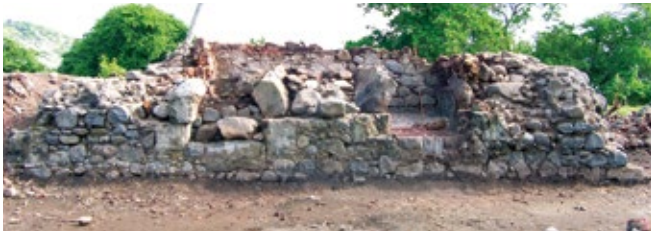
Fig. 2 : Four de potier, portes sous arcs en plein-cintre.
