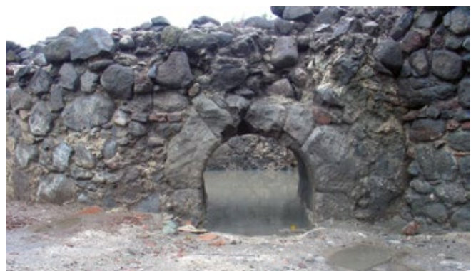
Fig. 2 : four à chaux.
