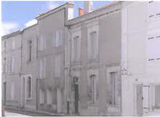
*Les enduits sont des revêtements épais que l'on applique sur la maçonnerie de façade.*
