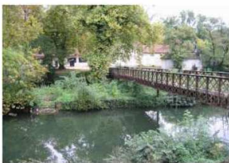
Passerelle métallique sur l'île Saint-Cybard
