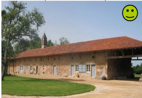
Ferme ancienne (Saint Trivier De courtes).
