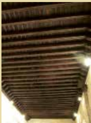
Vue générale de la charpente.
