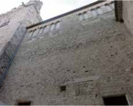
Une façade aveugle côté ville.
