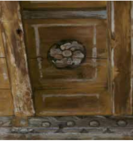
Pièce à l'arrière de la salle des Synodes, 1 er étage (XVI e siècle). Détail.
