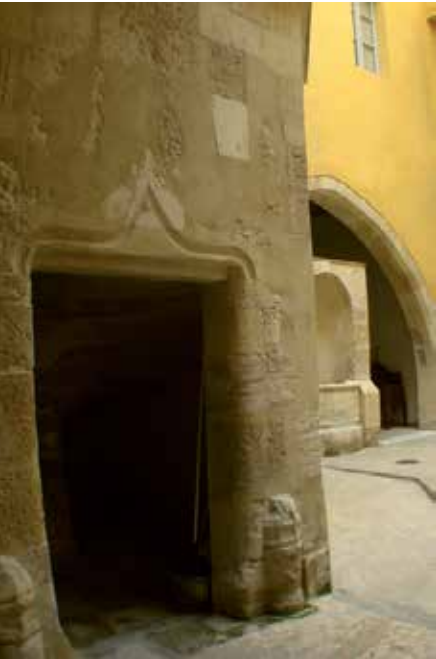
L'escalier en vis dans la cour.
