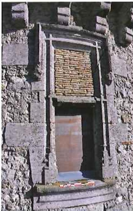
Figure 2 : Barbezieux-Saint-Hilaire, le châteleet d'entrée du château, fenêtre du dernier étage de la tour sud avec traverso, moulure à croiséc et bases pyramidales et le linteau en place (vue vers le nord-est)(Cliché : C. Chauveau).
