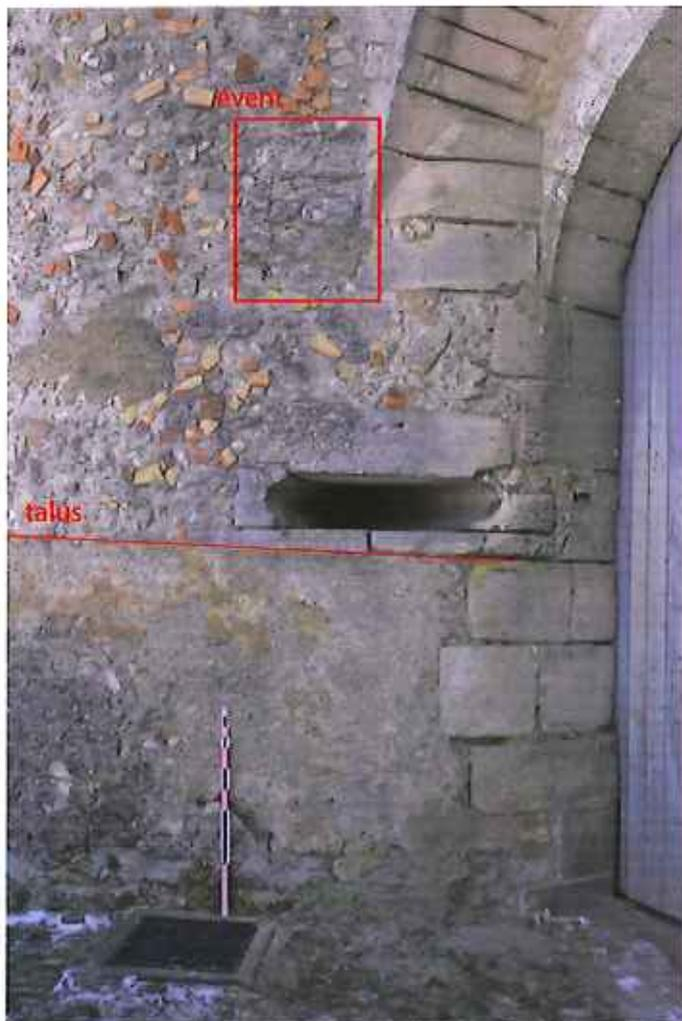
Figure 1 : Barbezieux-Saint-Hilaire, le châteleet d'entrée du château, canonnière axiale défendant le passage central du châteleet surmontée d'un évent rebouché et posée sur le talus défensif de la tour nord (vue prise vers le nord-est) (Cliché : C. Chauveau).
