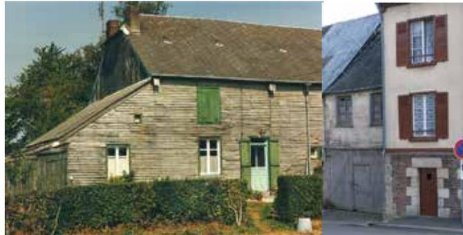
**La structure en pan de bois est rarement apparente.** Elle est le plus souvent cachée par un enduit ou un bardage (bois ou ardoise).
