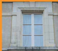
Enduit et encadrement en pierre
