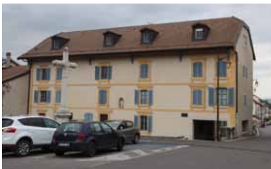
Avant et après travaux.
