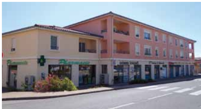
Côté ouest, les commerces font face aux équipements communaux.
