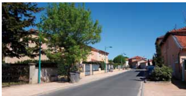
Front bâti : 4 logements groupés alignés à la rue dialoguent avec l'existant.
