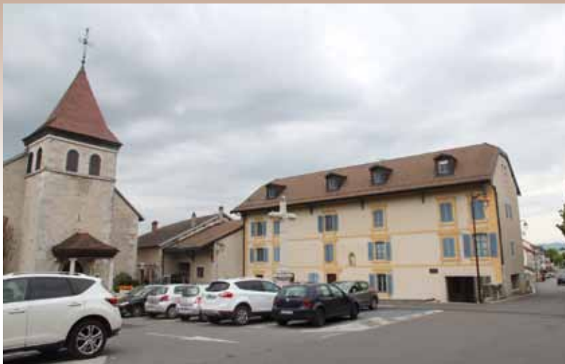
Restauration de la façade animant la place de l'église.
