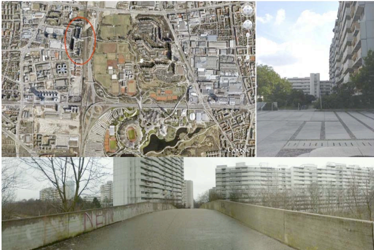
Olympia-Pressstadt, Angerer & Branca, Neue Heimat (1969-72), chantier industrialisé.
