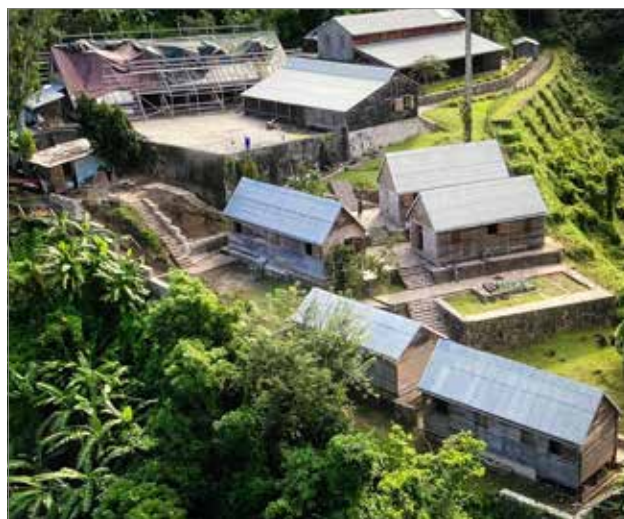
Vue d'ensemble du site de La Gravelière © Région Guadeloupe.
