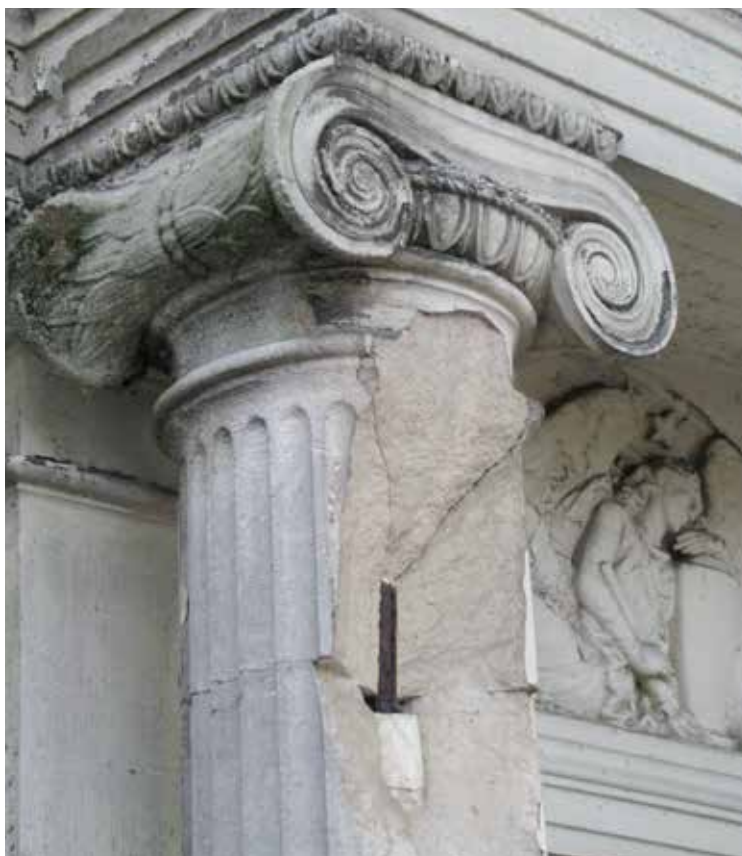
Éclatement de la pierre dû au gonflement des armatures internes en fer. Chapelle des familles Moraud, Brunet et Seailles. Cimetière de Montmartre, Paris.
