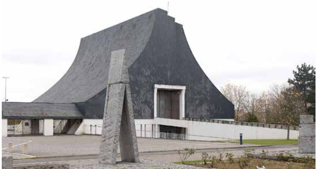
Funérarium du cimetière intercommunal de Valenton (Val-de-Marne).
