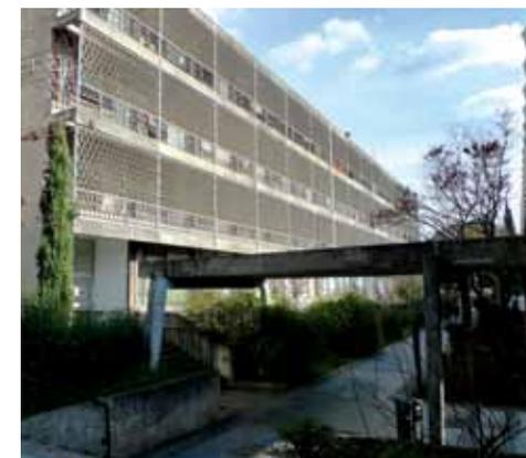
Cette structure était montée sur poteaux de tubes métalliques, incluant un système d'évacuation des eaux pluviales. En dessous, un tunnel dissimule la galerie technique. Des auvents, portiques ou bretelles de liaison, faits de dalles de béton armé sur poteaux à la base mince, relient ces circulations aux principaux bâtiments.
