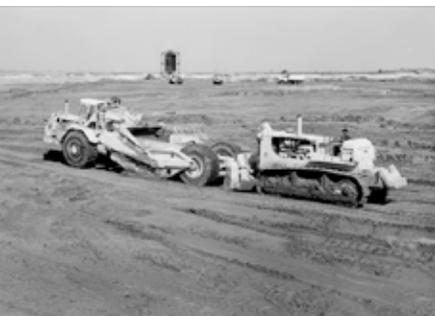
Le sable dragué à l'étang du Ponant est utilisé pour remblayer des sols du Levant, en 1966.
