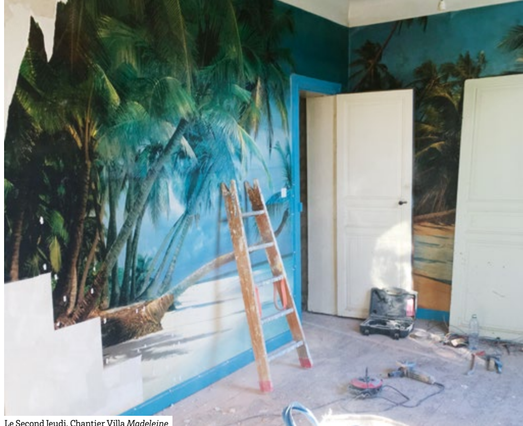
Le Second Jeudi. Chantier Villa Madeleine
