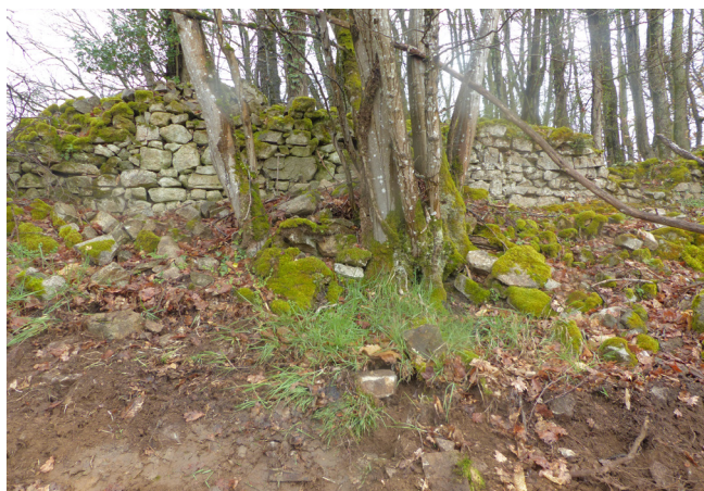
Isle - Rue Robert Schuman - Mur de clôture en pierre sèche
