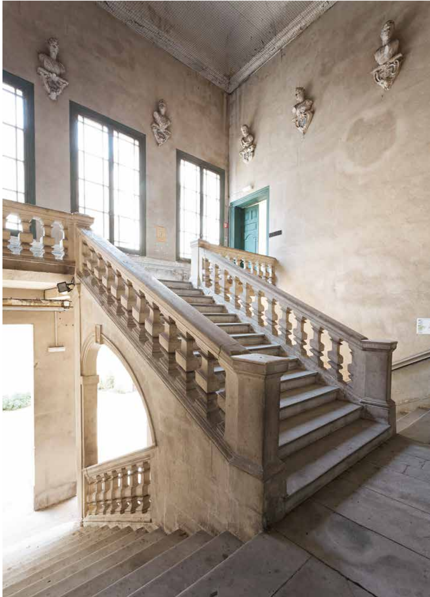
La cage d'escalier avant restauration.
